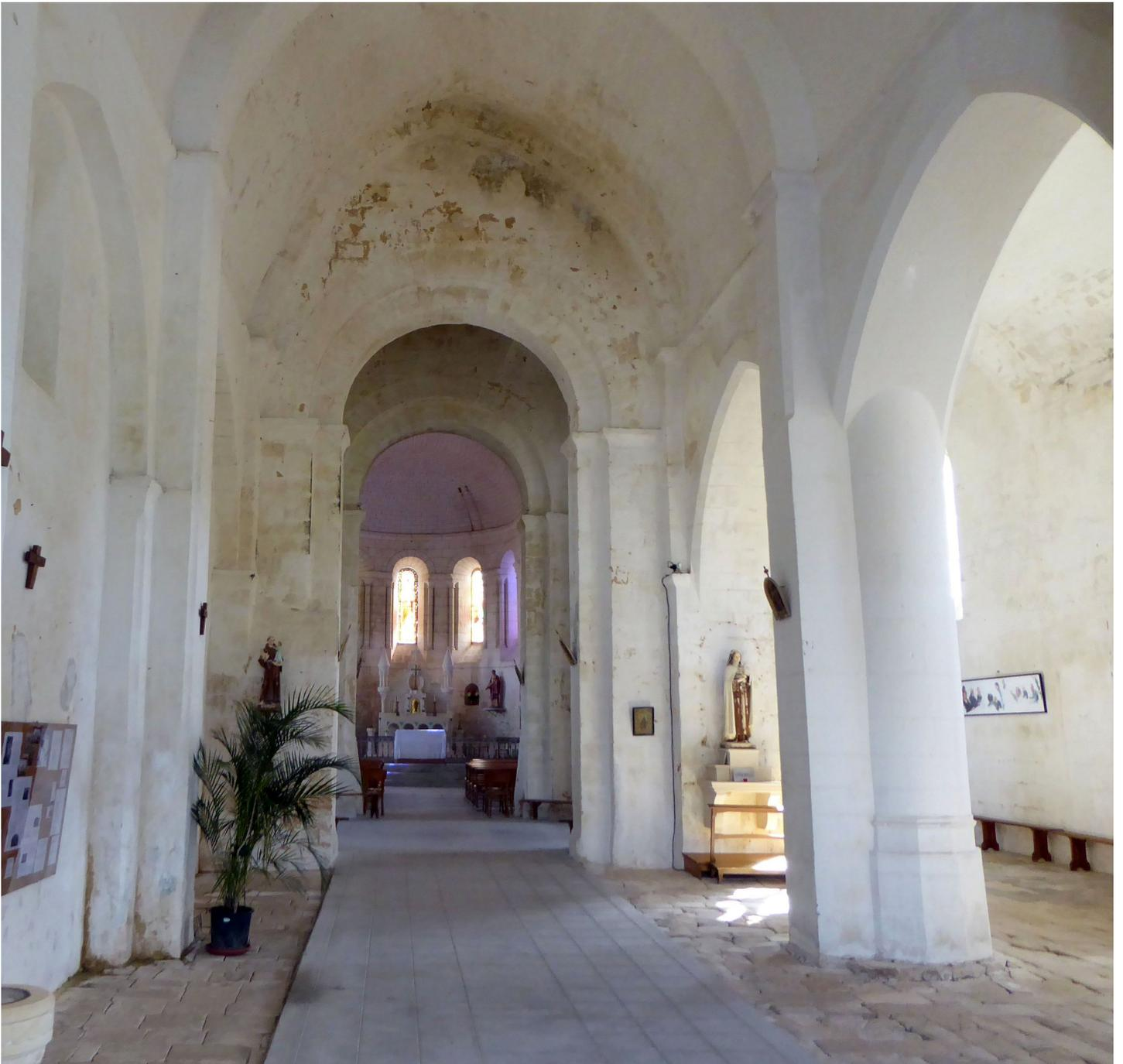
Au centre du vaisseau, quatre gros massifs de maçonnerie, groupes de pilastres carrés, toujours à impostes, réunis en tête par quatre arcs brisés, portent une coupole octogonale sur trompes avec trou à cloches. Le chœur (voûte de brique en plein cintre) communique avec ses collatéraux par de grandes baies brisées. Les fenêtres gothiques, sont à meneaux ou tréflées.
